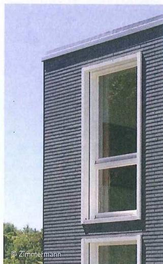
Particolare delle finestre a tutt'altezza e del rivestimento in legno.
