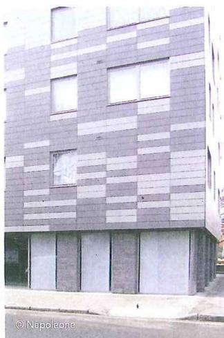
Dettaglio del sistema di rivestimento in pannelli di legno riciclato mineralizzato.
